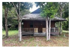
Bangunan Rumah Penjaga
